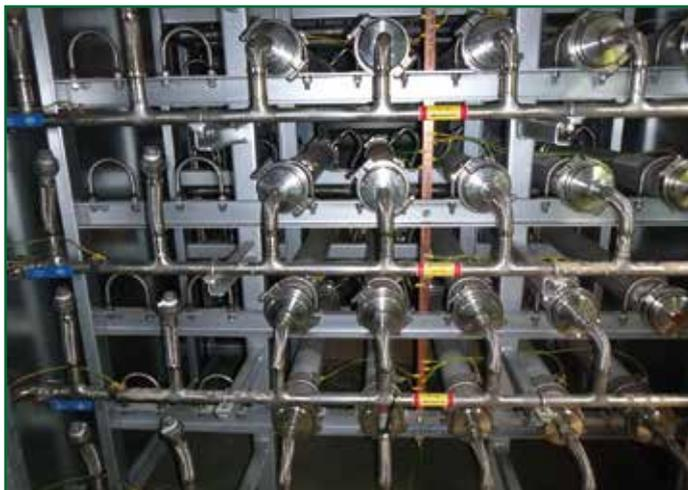
**Figura 5 – Membrane di separazione dell'impianto.**
