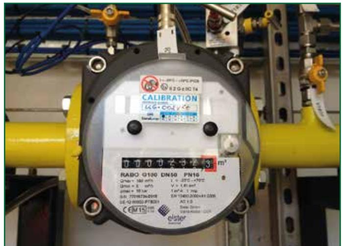
Figura 4 – Contatore gas.
