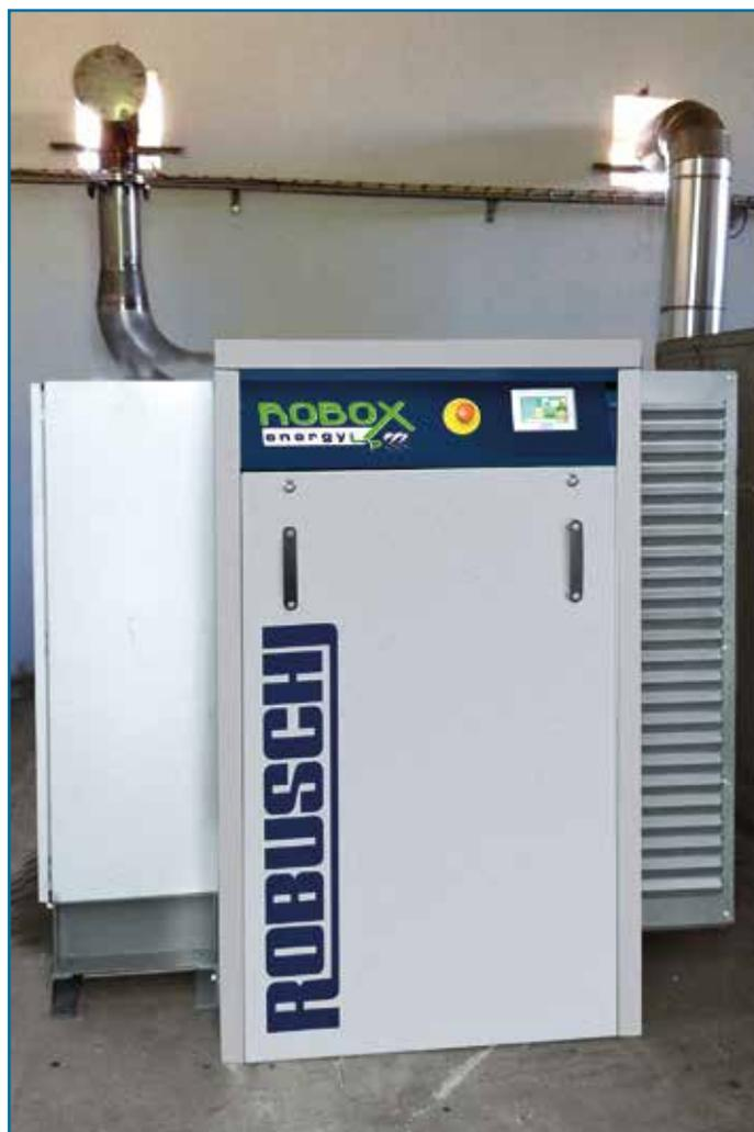
**Figura 2 – Nuovo compressore a vite con magneti permanenti ROBOX energy WS 85.**
