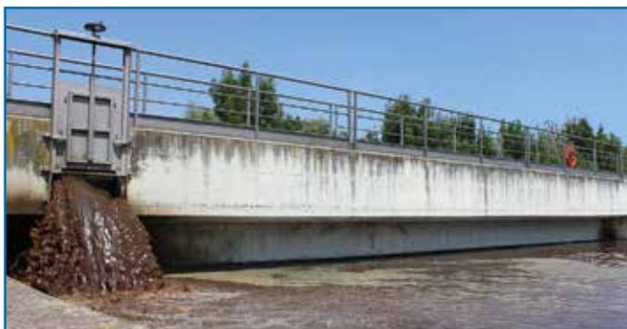
**Figura 3 - I fanghi trattati sono particolarmente abrasivi, perché molto mineralizzati e con presenza di limi.**
