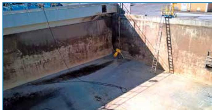
**Figura 4 - I tecnici Xylem hanno studiato il dimensionamento ideale per una vasca di denitrificazione da 2.200 m³.**
