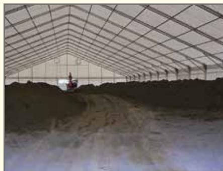
**Figura 2 – Biopile sotto tensostruttura.**
