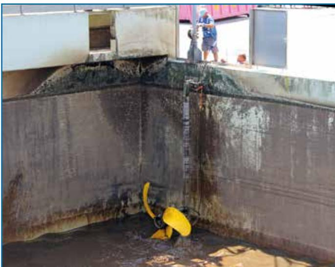
**Figura 7 – Il particolare profilo delle pale previene il rischio di intasamento.**
