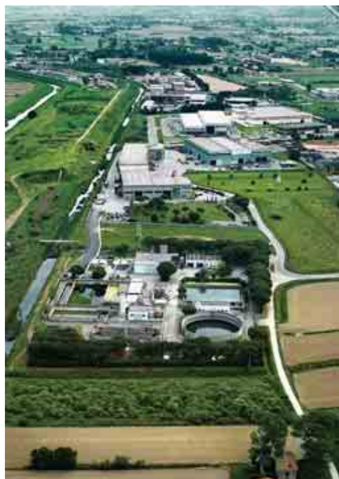
Figura 4 - Foto aerea del sito della Waste Recycling, con le due vasche di ossigenazione reflui.
