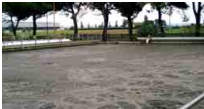
Figura 3 - Vasche impianto depurazione della Waste Recycling.
