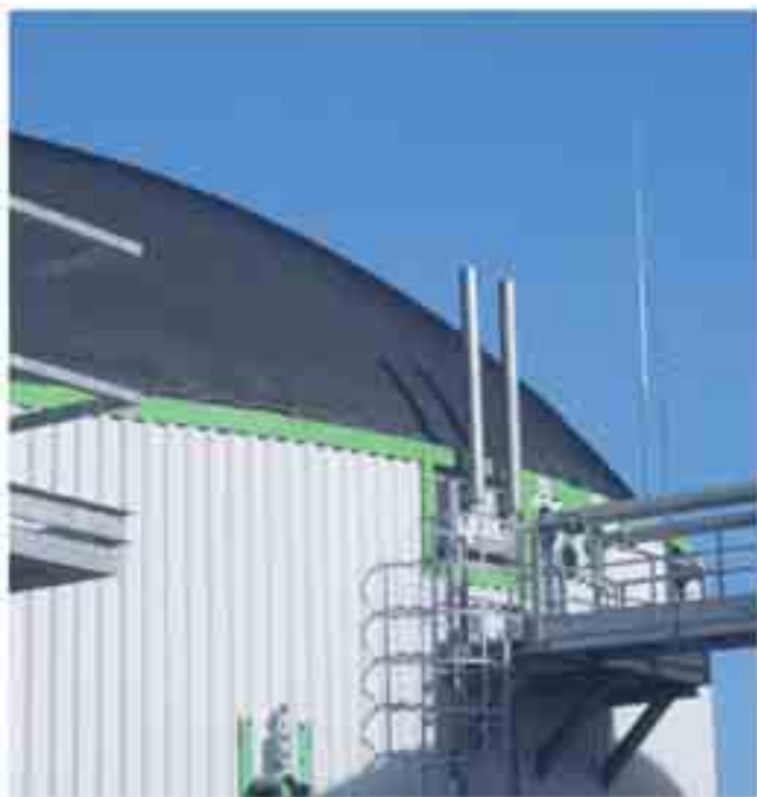
Figura 1 – Valvola di sicurezza a guardia idraulica.
